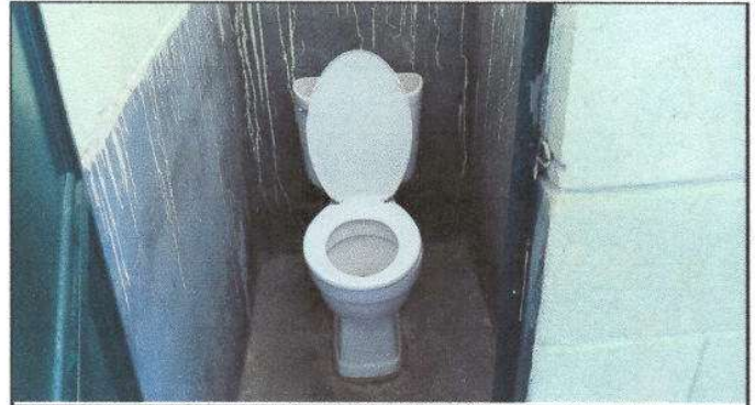
Foto 2: Sustitucion de accesorios inodoro
