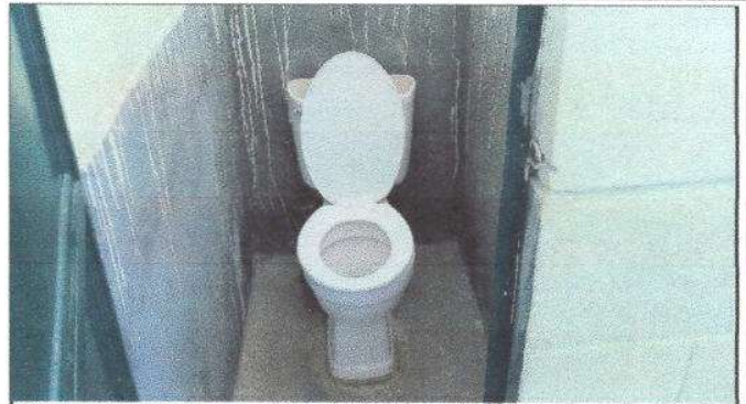
Foto 2: Sustitucion de accesorios inodoro
