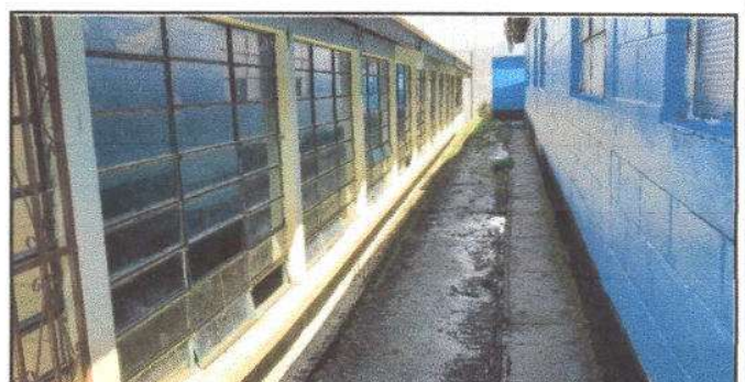
Foto 6: Fabricacion instalacion de balcones de hierro en ventana
