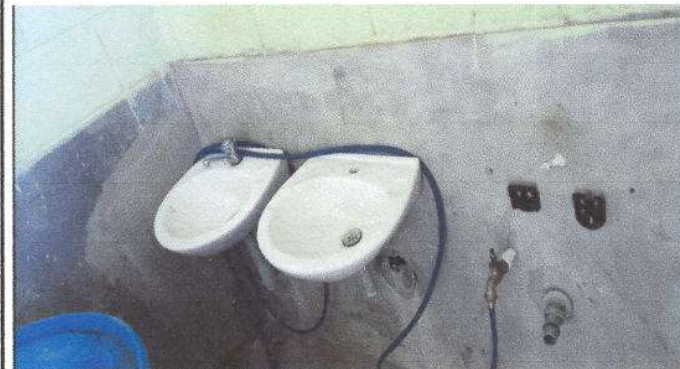
Foto 3: Sustitucion de lavamanos
