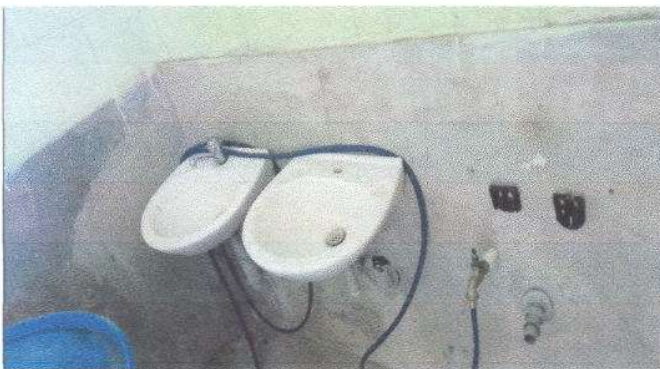
Foto 3: Sustitucion de lavamanos
