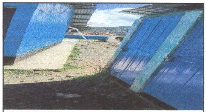
Foto 4: Sustitucion de tuberia PVC linea principal de aguas negras
