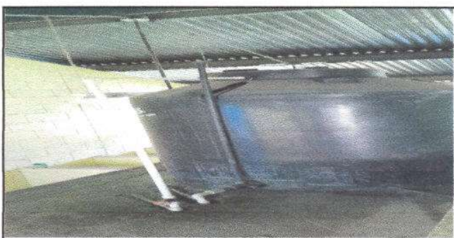
Foto 5: Sustitucion de accesorios de deposito de agua
