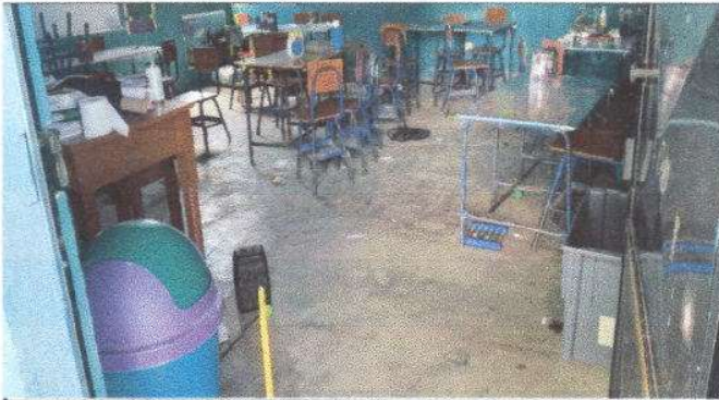
Foto1: Sustitucion de piso de torta de concreto
