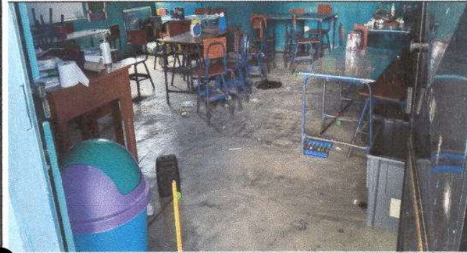
Foto1: Sustitucion de piso de torta de concreto
