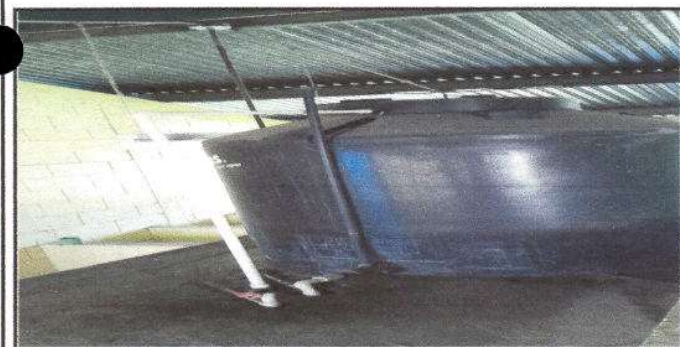
Foto 5: Sustitucion de accesorios de deposito de agua
