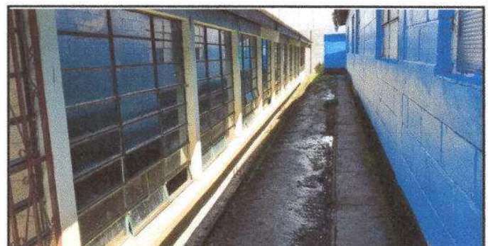
Foto 6: Fabricacion instalacion de balcones de hierro en ventana
